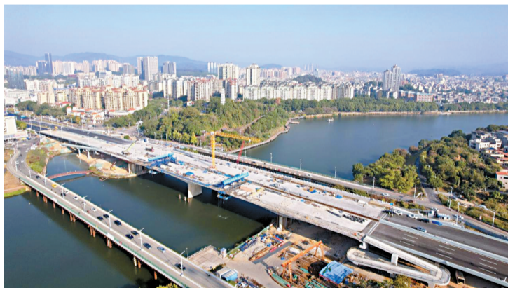
■ 国道G324线雁塔大桥左幅主桥合龙段合龙。通讯员供图
