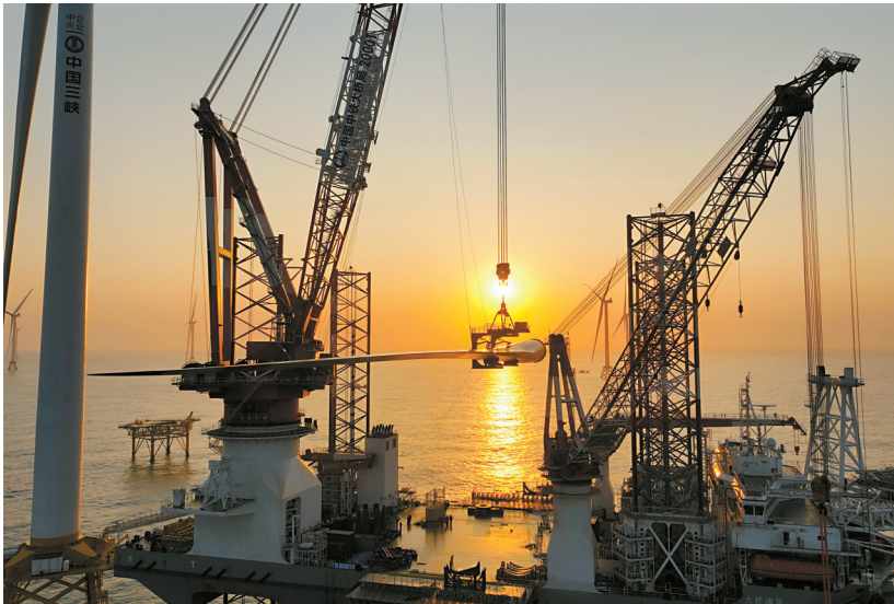
■1月13日,20兆瓦风电机组叶片在闽南海域完成吊装。新华社发
