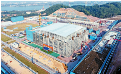
■2025年12月18日,500千伏古劳换流站阀厅网架完成提升。 张晓杰/摄
