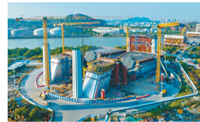
狮子洋通道春节期间,持续推进锚碇桥体施工。
