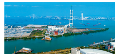
建设中的狮子洋大桥。
