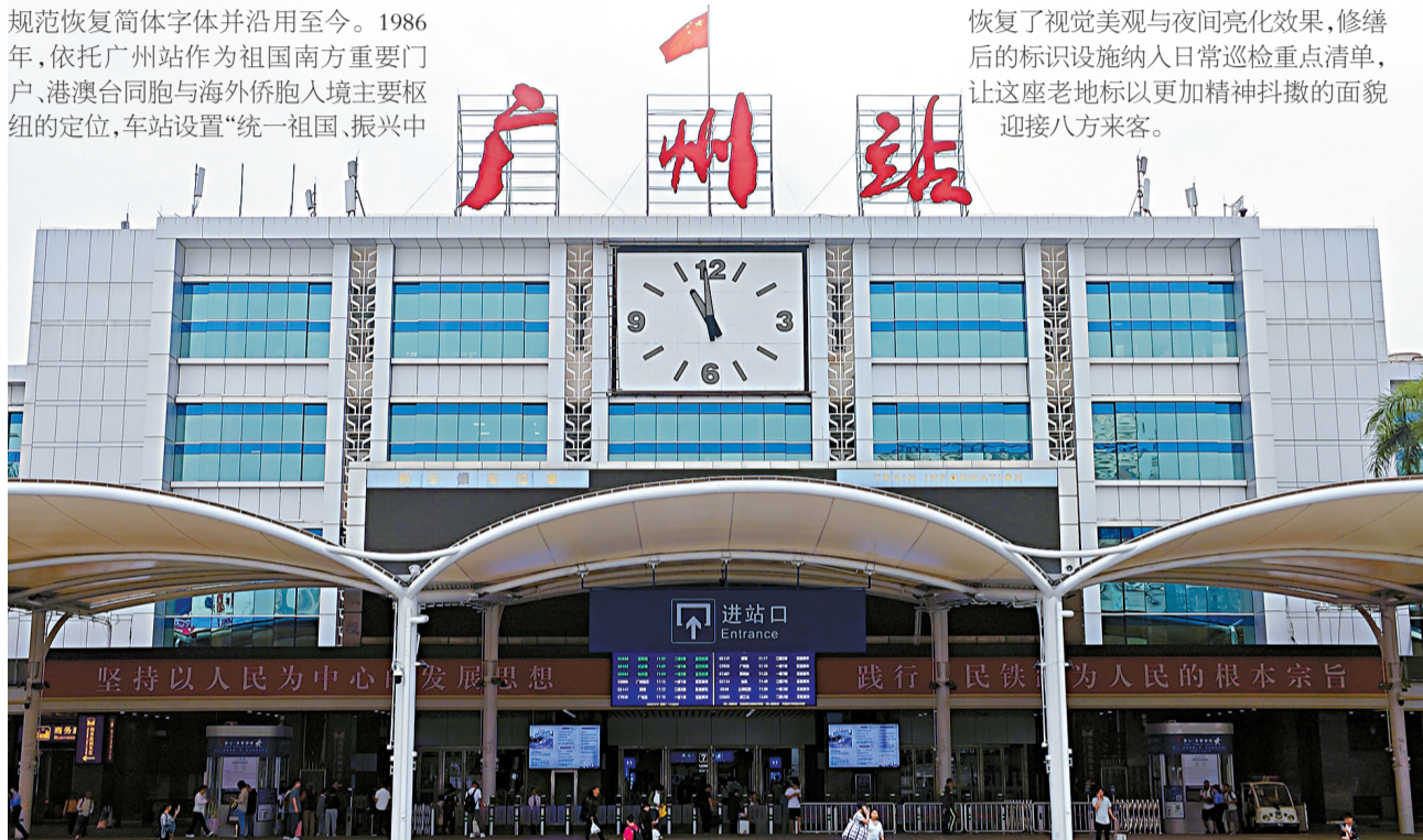
■作为广州城市地标的广州站楼顶“广州站”标识近日顺利完成专项修缮。(通讯员供图)
