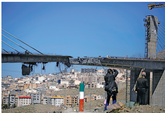
■4月2日,伊朗卡拉季市贝伊克公路桥遭美国和以色列两次空袭受损。这是4月3日拍摄的该公路桥遭空袭受损状况。伊朗战事目前没有缓和迹象。
