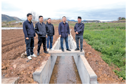
■四方村修好400米水渠,惠及500多亩农田。
