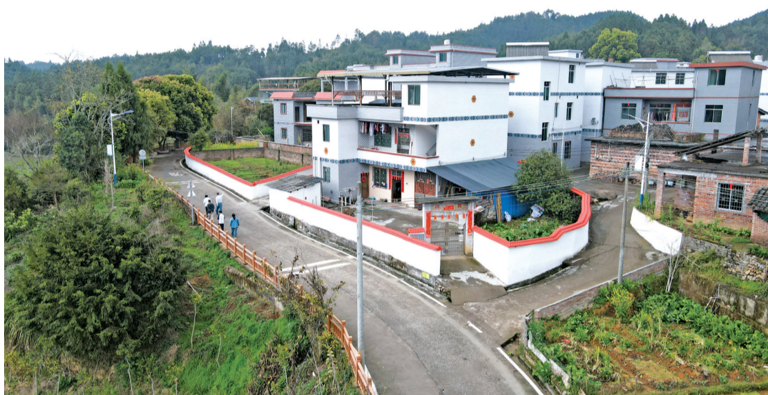
■禾洞镇禾坪村大坪自然村,经过外立面改造后的农房焕然一新。
