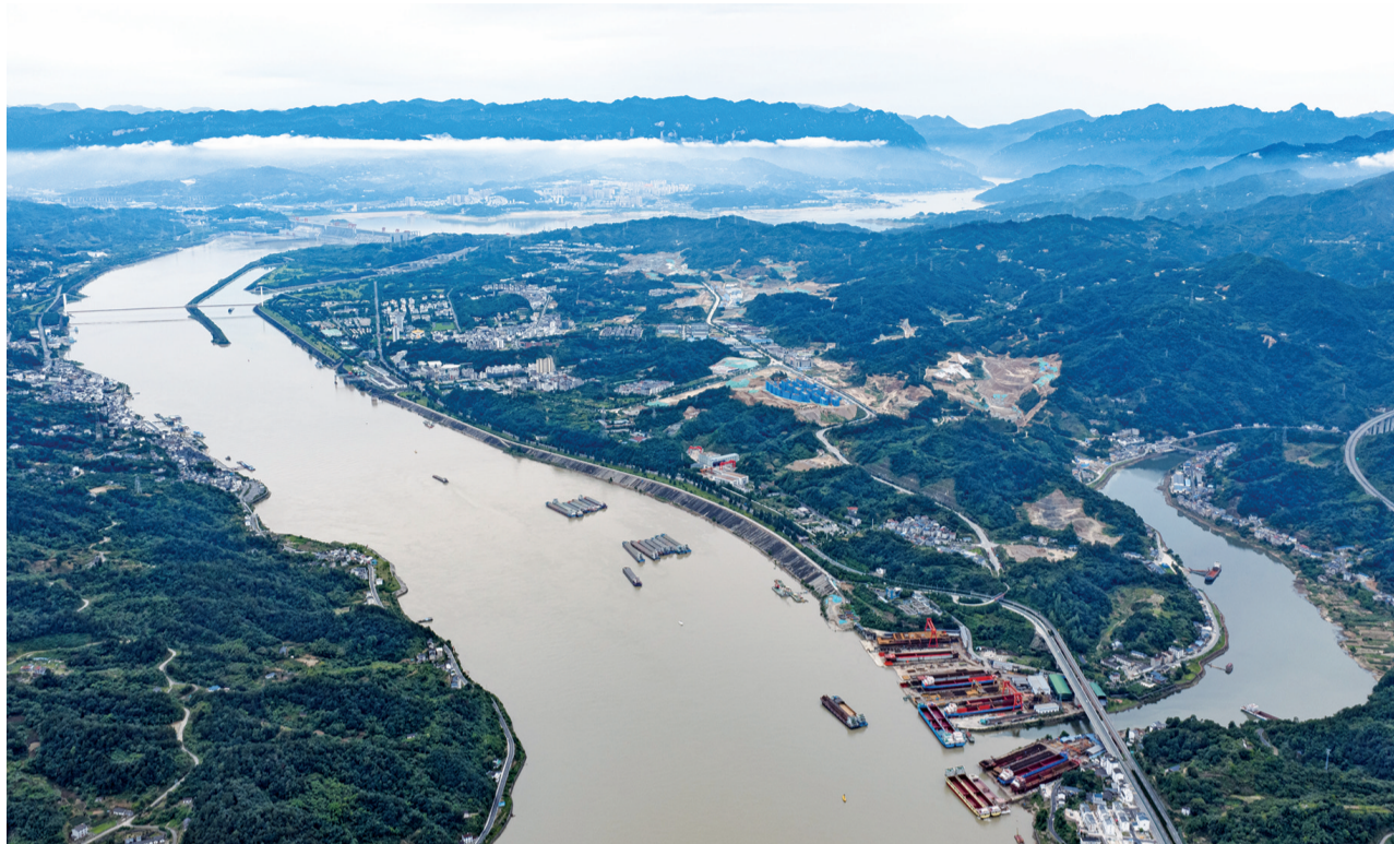
■6月8日拍摄的三峡水运新通道工程三峡枢纽新通道施工现场。
