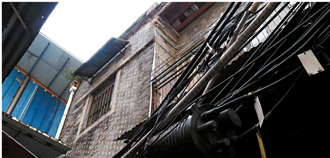
■被拆除的传统风貌建筑西来西34号。
