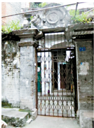
■被拆除的传统风貌建筑线索毓桂坊4号。
