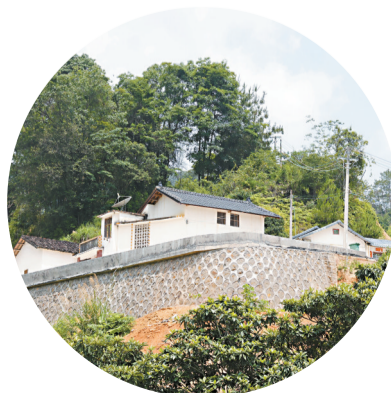
■双髻山村圣塘小组的农房有了新修的斜坡护住,更为安全。
