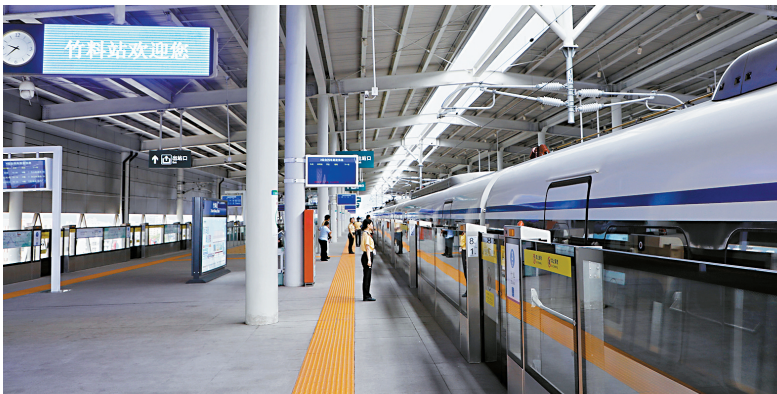
■穗深城际铁路竹料站。 新快报记者 毕志毅/摄
