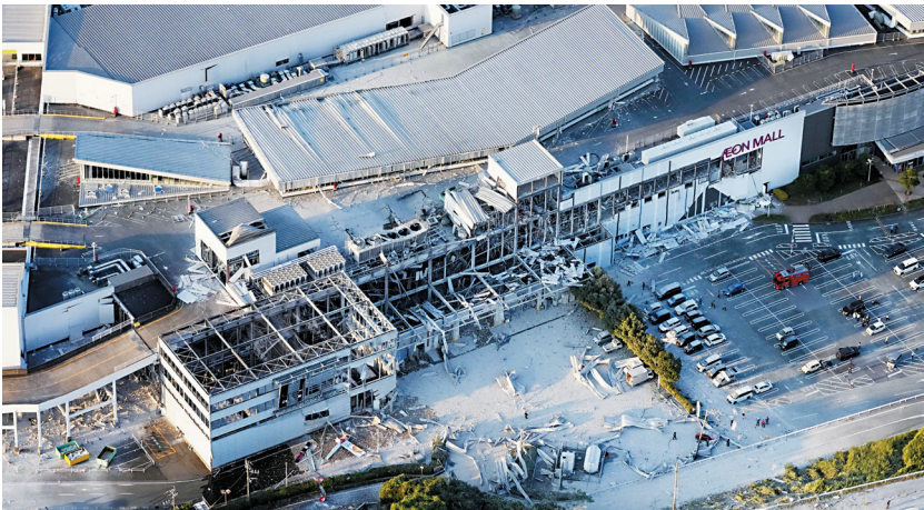
■7月28日,日本熊本县一商场在地震中发生坍塌。 新华社发
