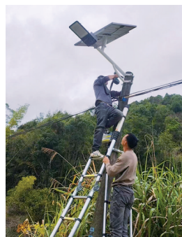
■经过多方共同努力,太阳能路灯已全部安装完成。
