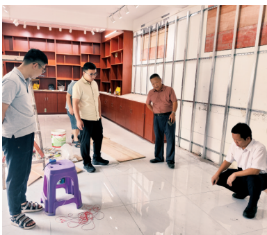
■在施工现场,工作队队员对照项目设计标准细致核查施工细节。
