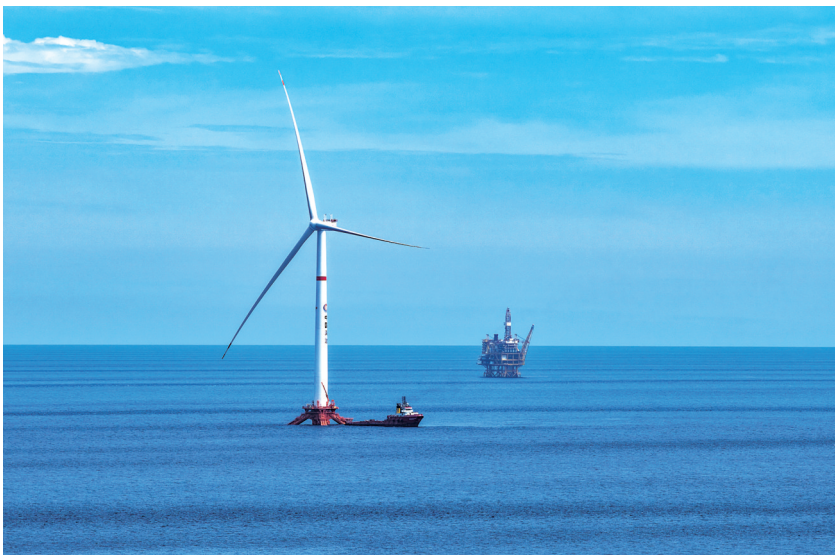
■“海油安澜号”成功接入陆丰油田电网并直供绿电。(央视)
