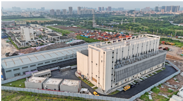
■220千伏茶山(石埗)输变电工程竣工投产。
