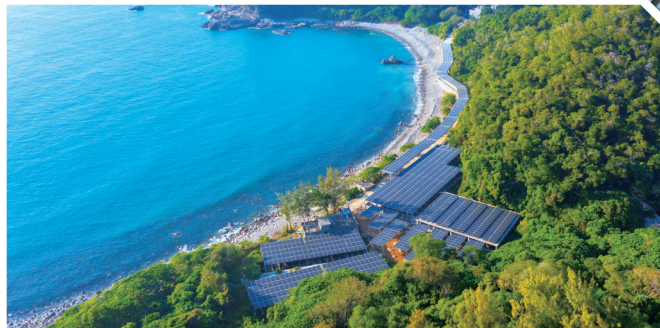
■碧海青山间,三门微电网光伏阵列沿海岸线铺展。
