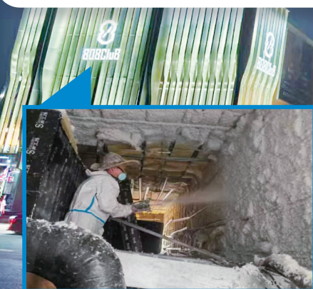
▲808CLUB在整改装修过程中为墙体喷涂了隔音材料。(受访者供图)
