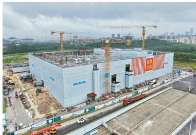
■广棠科创城具身智能产业园项目主体结构8月28日封顶。 通讯员供图
