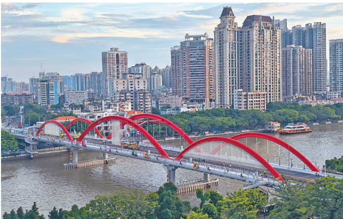
■经过近5个月的紧张攻坚,解放大桥维修工程即将完工,计划于8月31日零时正式恢复通车。 新快报记者 毕志毅/摄
