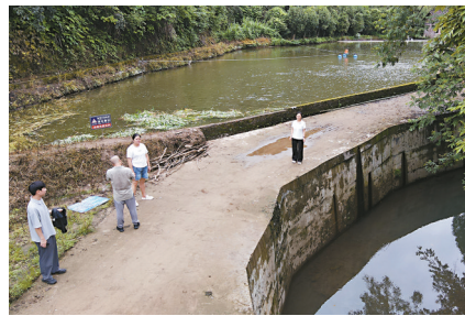
■工作队在清水村委会黄屋村了解道路坍塌修复工程项目成效。
