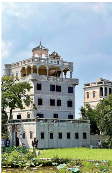
■铭石楼是自力村最具特色的建筑之一。
