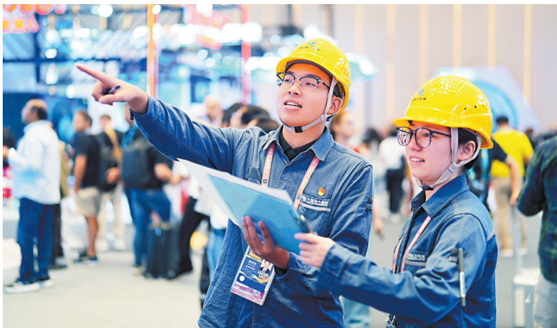
■杨宏钧(左)与同事在琶洲广交会展馆检查电力供应设备。
