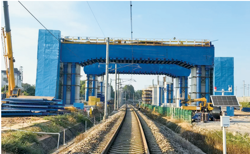
■合湛高铁全线首座门式墩浇筑完成。
