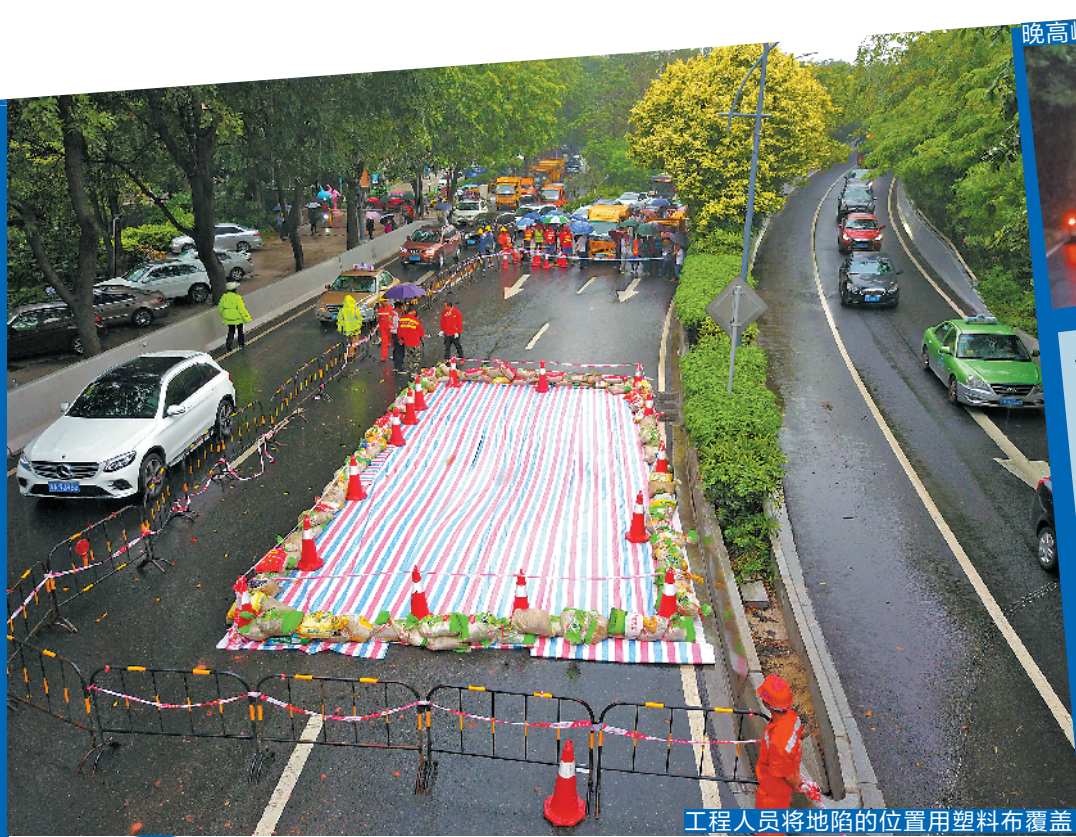
工程人员将地陷的位置用塑料布覆盖
