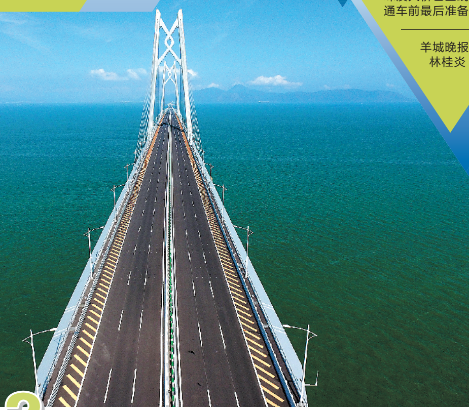
一桥飞架三地,碧海终成通途。有“超级工程”美誉的港珠澳大桥已全线贯通,进入通车前最后准备阶段
