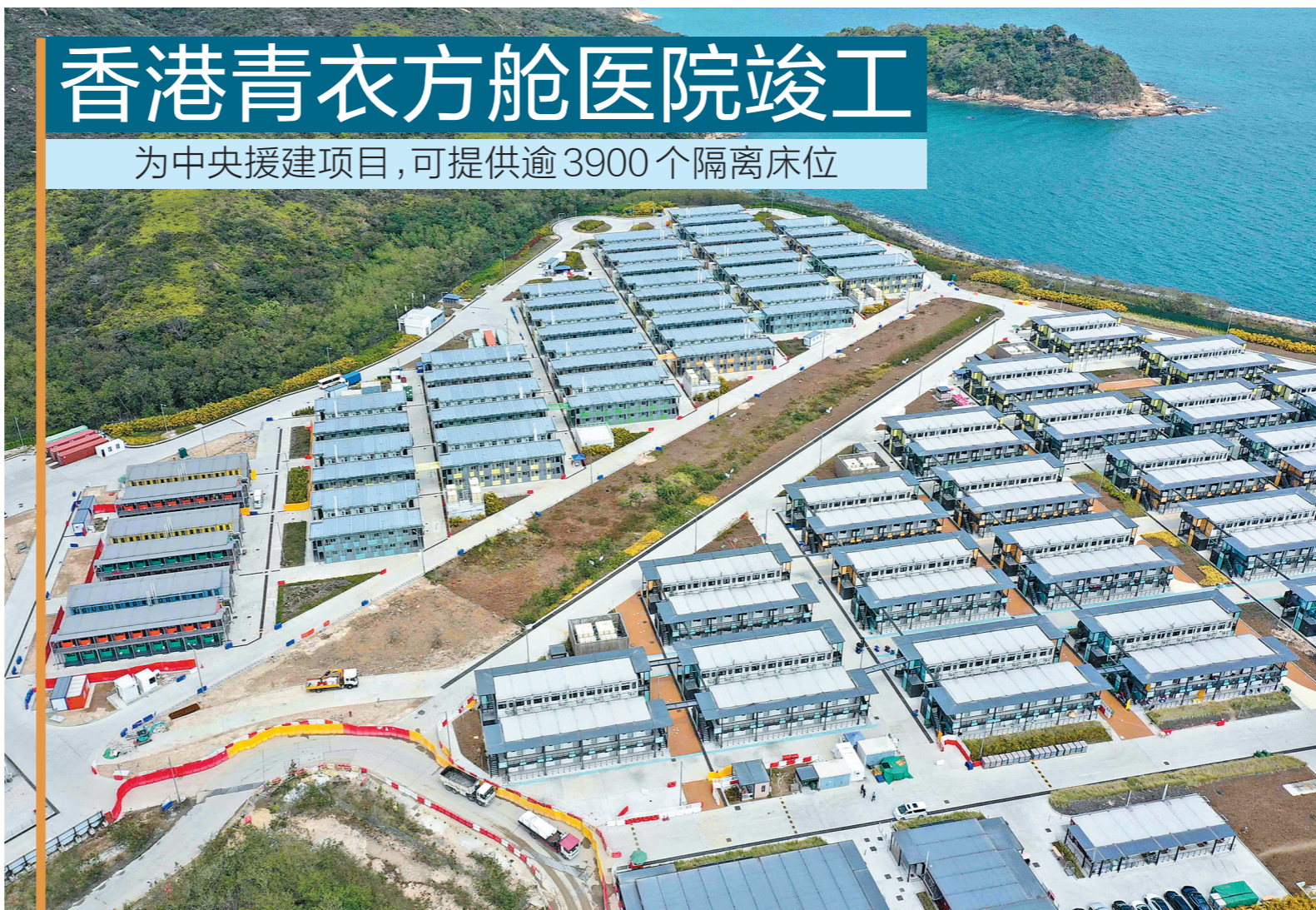
青衣方舱医院2月22日开工后24小时不间断施工,28日竣工,“短短七天为香港创造了一个奇迹”人民视觉供图
