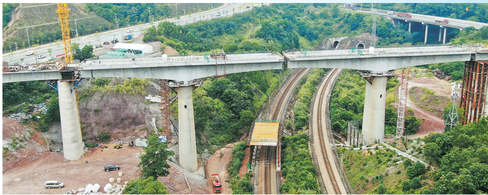
上图为转体前的广汕高铁跨京九铁路特大桥连续梁；下图为转体后的广汕高铁跨京九铁路特大桥连续梁 新华社发
