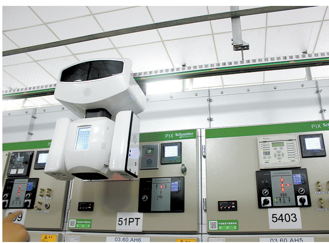
巡检机器人提升了炼铁生产智能化水平
