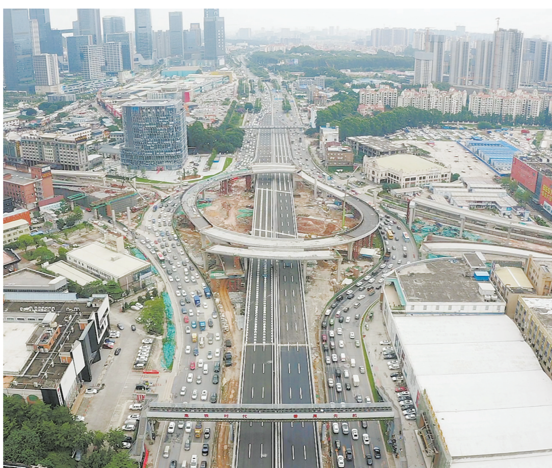
番禺大道主线跨线桥全长共1.15公里,采用双向六车道 通讯员供图
