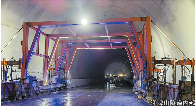
迎牌山隧道内部
