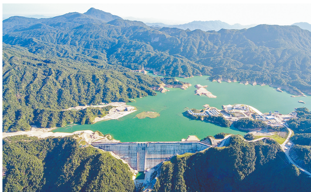
阳江百万千瓦级抽水蓄能电站 曹耀安 摄
