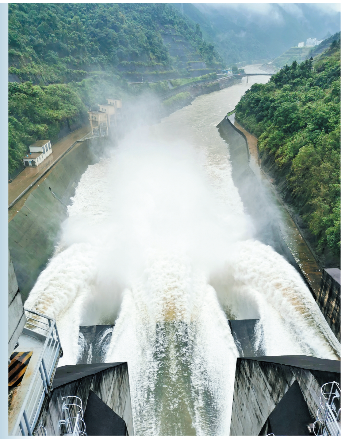
乐昌峡水利枢纽腾空库容
