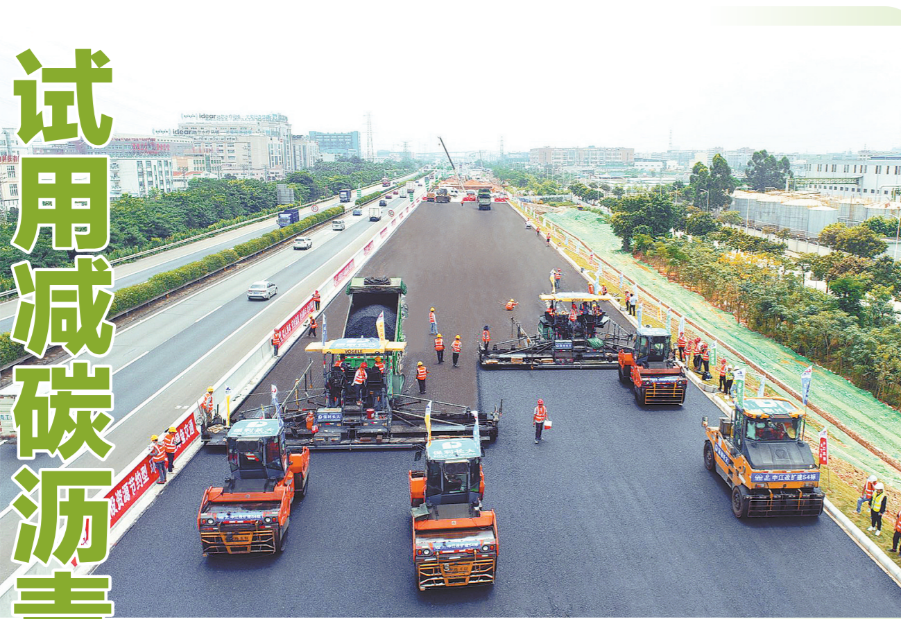
近日,中江高速改扩建率先试用减碳沥青进行路面摊铺,成为全国首条试用减碳沥青的高速公路
