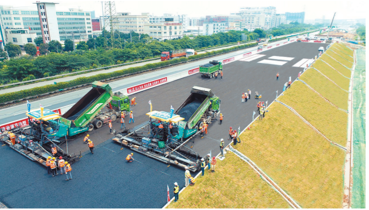
路面摊铺现场
