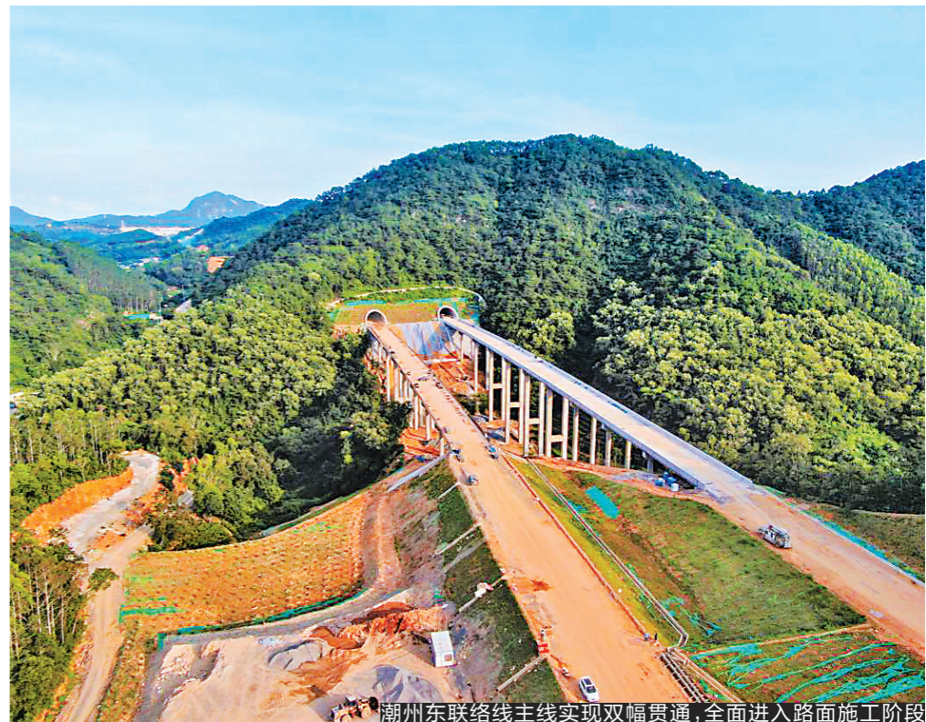
潮州东联络线主线实现双幅贯通，全面进入路面施工阶段
