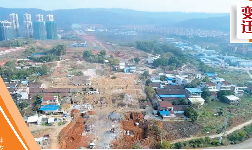
2017年，建设中的芙蓉大道南 通讯员供图
