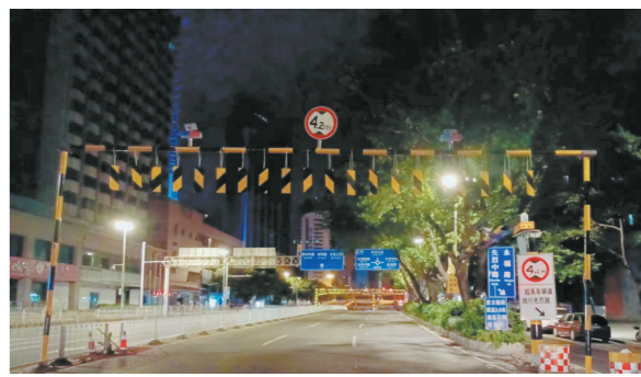
环市东路区庄立交被撞位置已经安装简易门架 受访方供图
