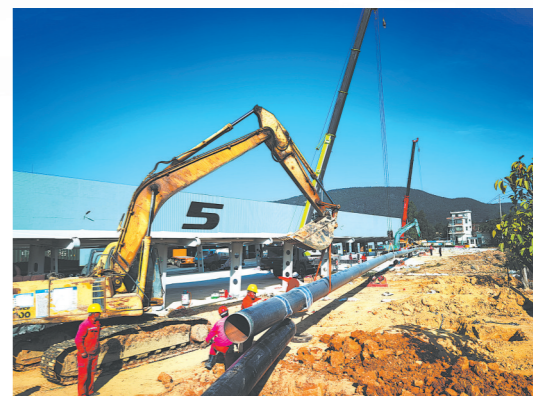
肇庆佛燃“煤改气”专线建设
