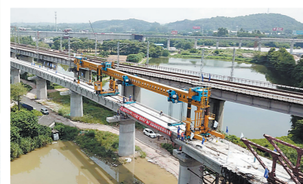
鹤市河特大桥连续梁施工现场
