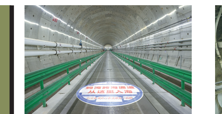
妈湾海底隧道在建工程
