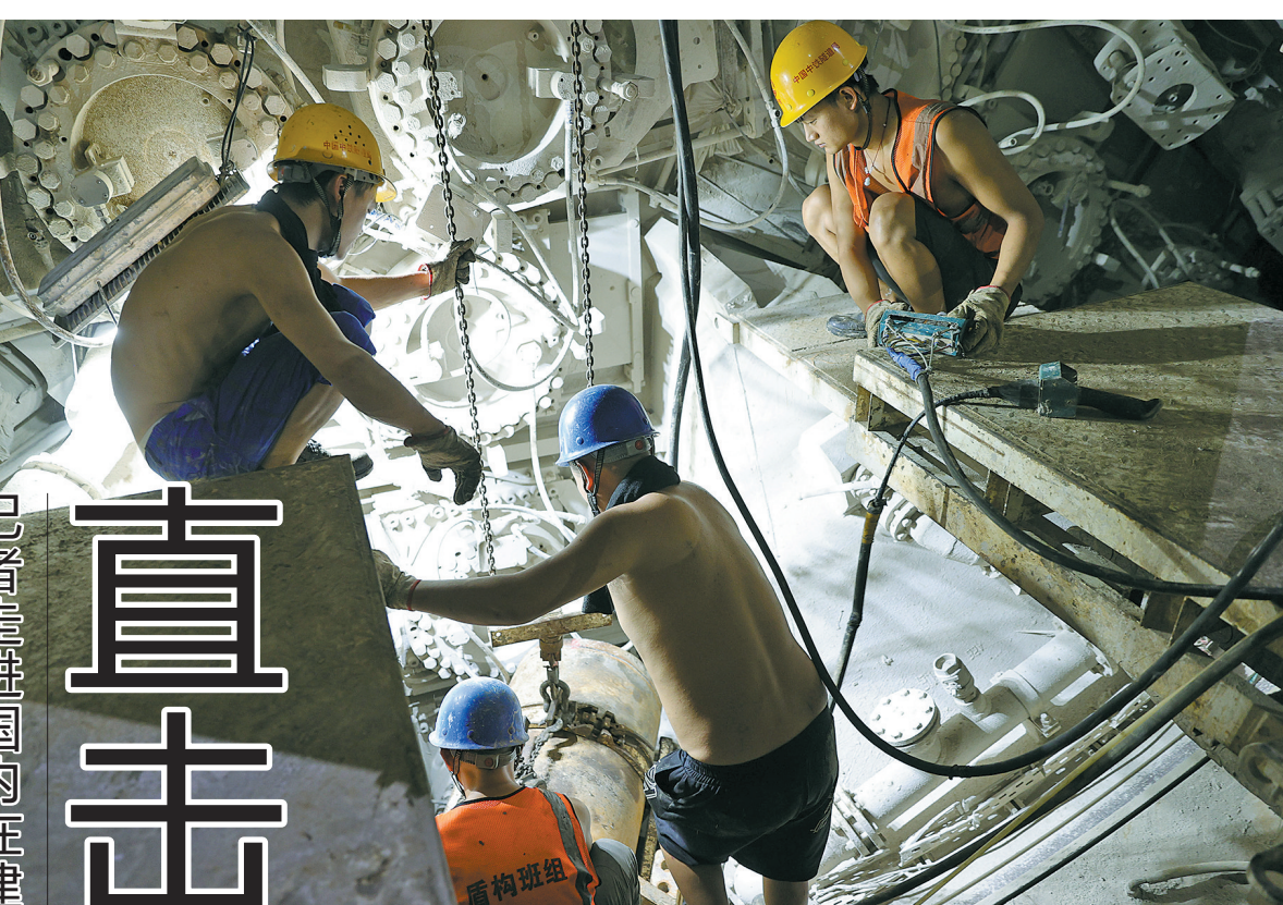
工作人员在刀盘内部进行常压换刀
