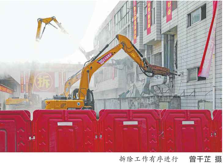
拆除工作有序进行 曾千芷 摄
