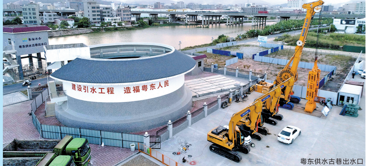
粤东供水古巷出水口
