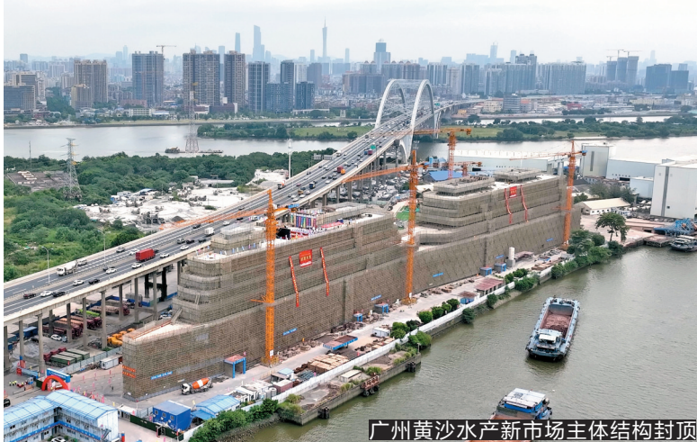
广州黄沙水产新市场主体结构封顶
