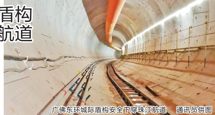
径小曲线穿越长度达890米的珠江航道，该段隧道顶部最大埋深22.8米，隧道洞身主要穿越地层为中风化、强风化含砾砂岩地层，节理裂隙较发育，隧道覆土为全风化、砂层和淤泥，部分区段上部覆土无全风化和淤泥等隔水层，开挖面与江水存在水力联系，施工风险和难度高。
