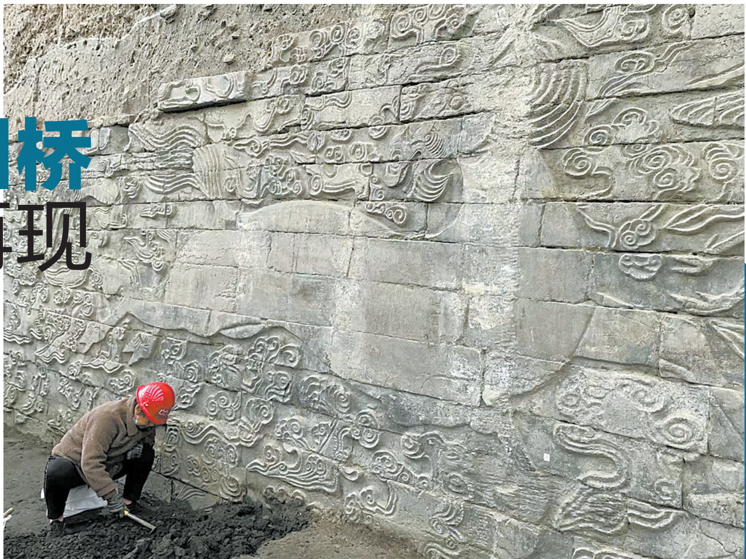
州桥南岸石壁上的“海马”瑞兽依然气韵流动，它身上的白色痕印，是原址上方的现代建筑在施工打桩时擦过石壁所致 羊城晚报记者 邓琼 摄
