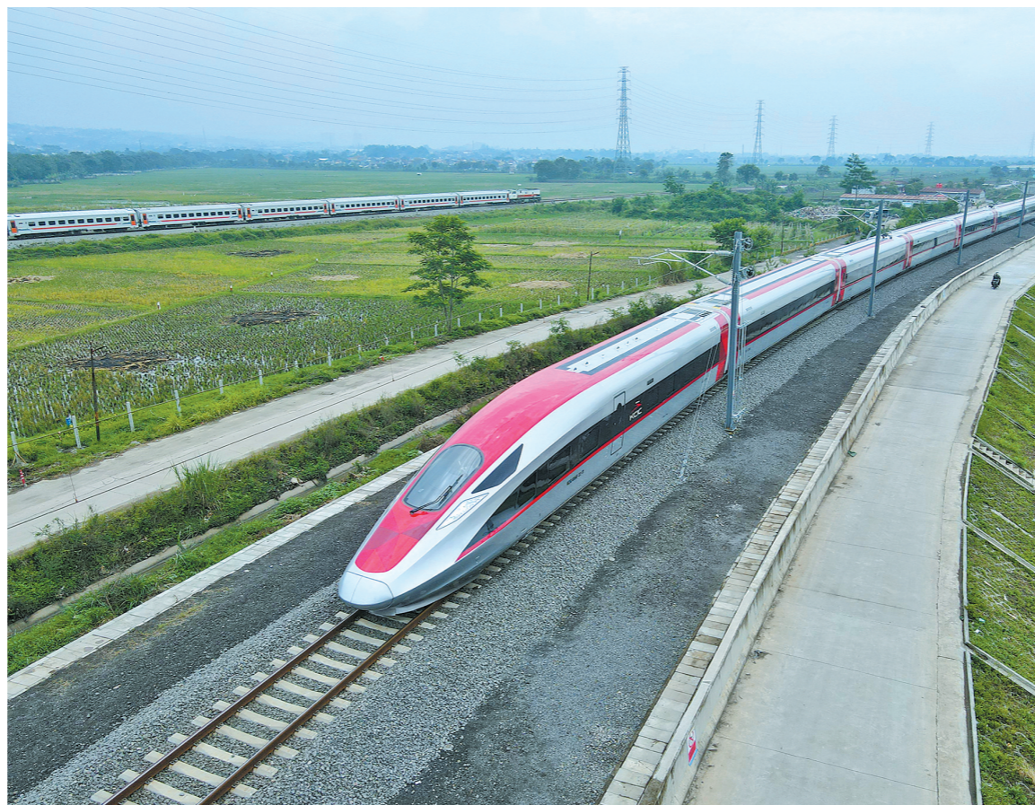
在印度尼西亚西爪哇省万隆市，一列高铁动车组正在雅万高铁试验段进行热滑试验 新华社发
