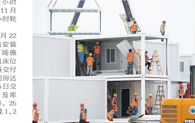
南沙健康驿站施工人员日夜赶工 羊城晚报记者 宋金岭 周巍 摄
