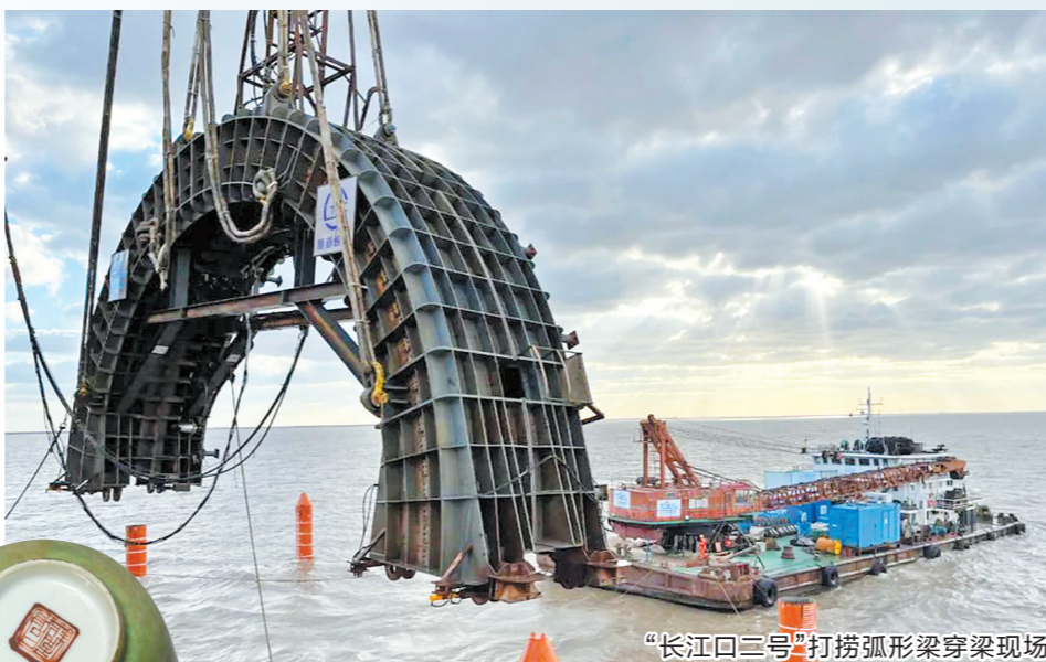
“长江口二号”打捞弧形梁穿梁现场
