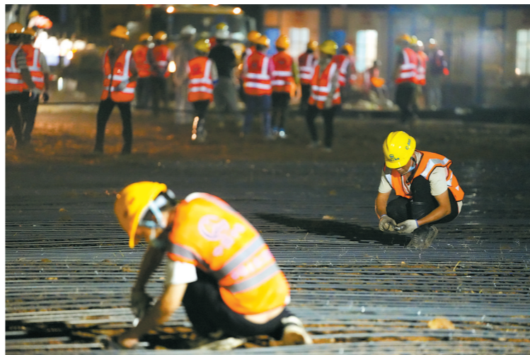
夜晚，南沙健康驿站，工人们铺设钢筋
