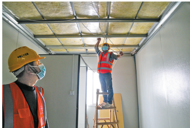
11月22日，来自湖南的38岁水电工陈平正在完成室内水电安装
