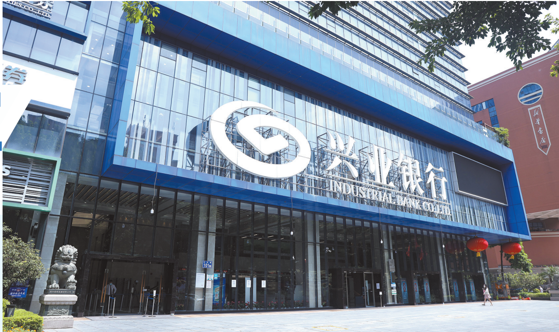
兴业银行广州分行大楼外观图
