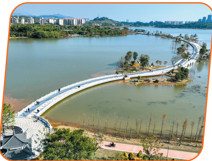
东西向连通荔湖的增城区荔湖碧道连通改造工程
