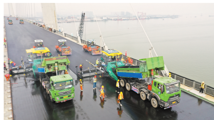
摊铺机和压路机正在作业
